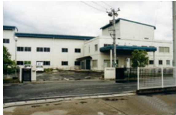
大崎広域リサイクルセンター （燃えないごみの処理施設）
