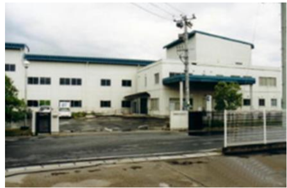
大崎広域リサイクルセンター （燃えないごみの処理施設）
